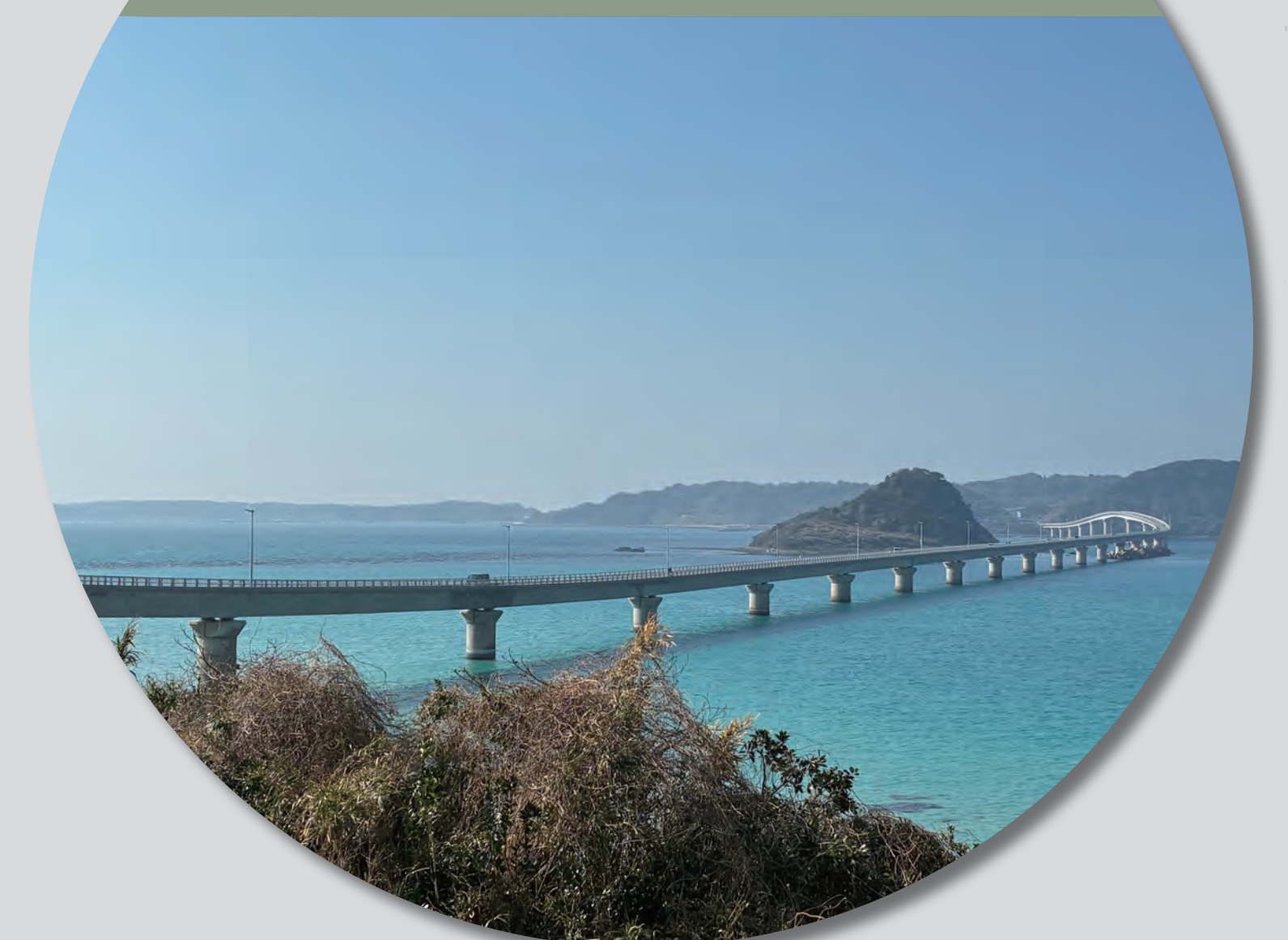
高耐久のコンクリートが使われている角島大橋
