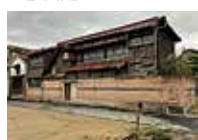
B-4 桃色煉瓦造・空き家
